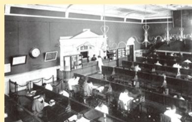
旧館大閲覧室
